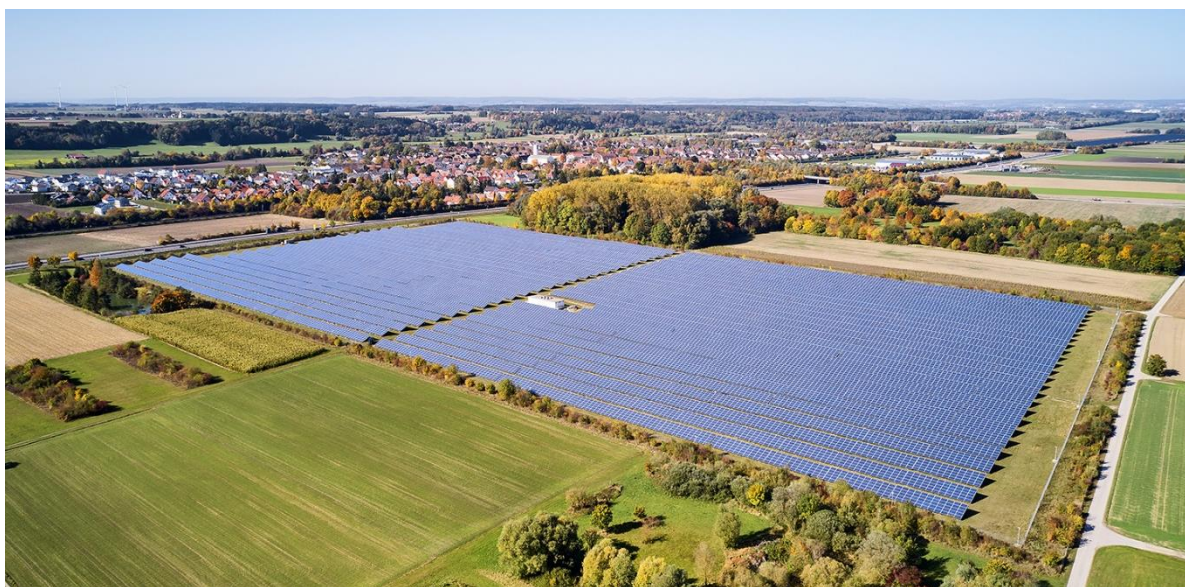
Unser Solarpark Nordendorf. Der erste Solarpark von hep in Deutschland.
